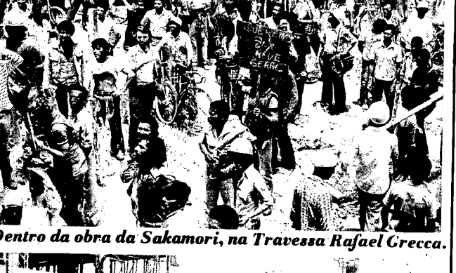
Dentro da obra da Sakamori, na Travessa Rafael Grecca.
