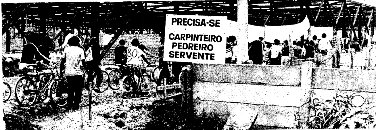
Algumas placas em obras, lembram a possibilidade da demissão em massa, mas não intimidam a classe.
